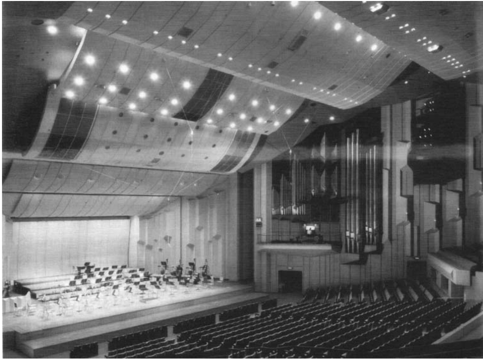
Fig. 10 Esempio di struttura riflettente a soffitto continua, realizzata in forma di grandi vele appese al vero soffitto (NHK Hall di Tokyo: aperta nel 1973, 25.200 m 3 , 3.677 posti, T_{Rm} = 1,7 s) (Beranek, 1996).
