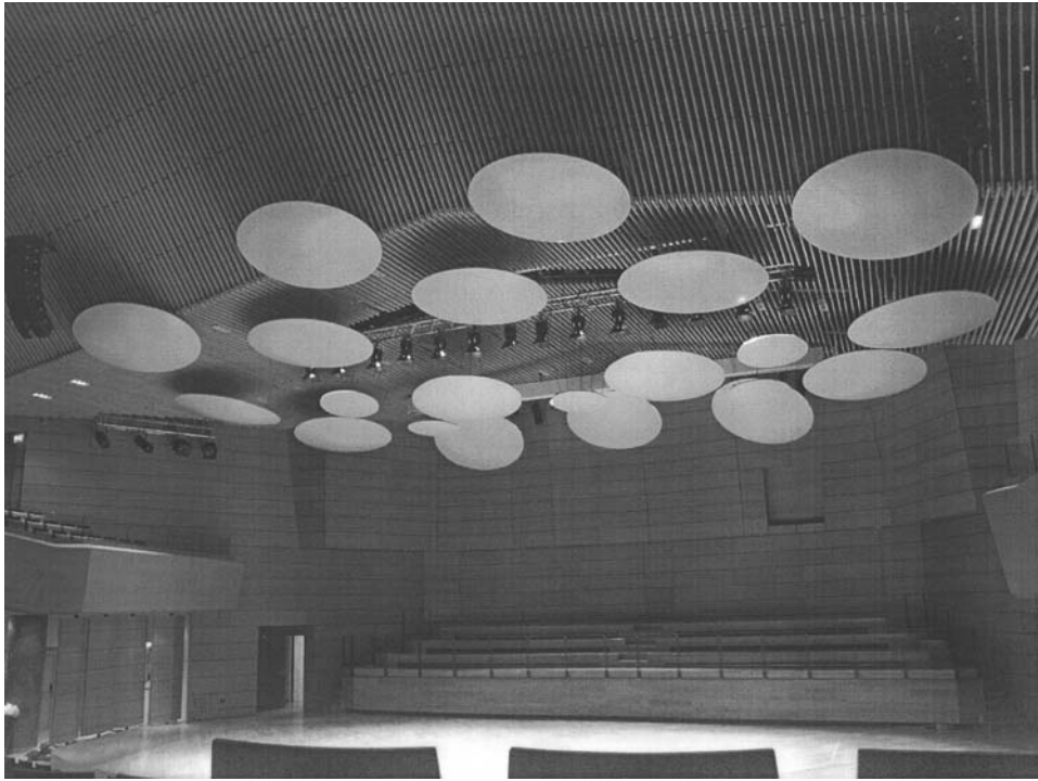
Fig. 17 Riflettori sul palcoscenico realizzati in forma di dischi leggermente convessi (Teatro Dal Verme, Milano: 10.500 m 3 , 1.463 posti) (Foto INRiM).
