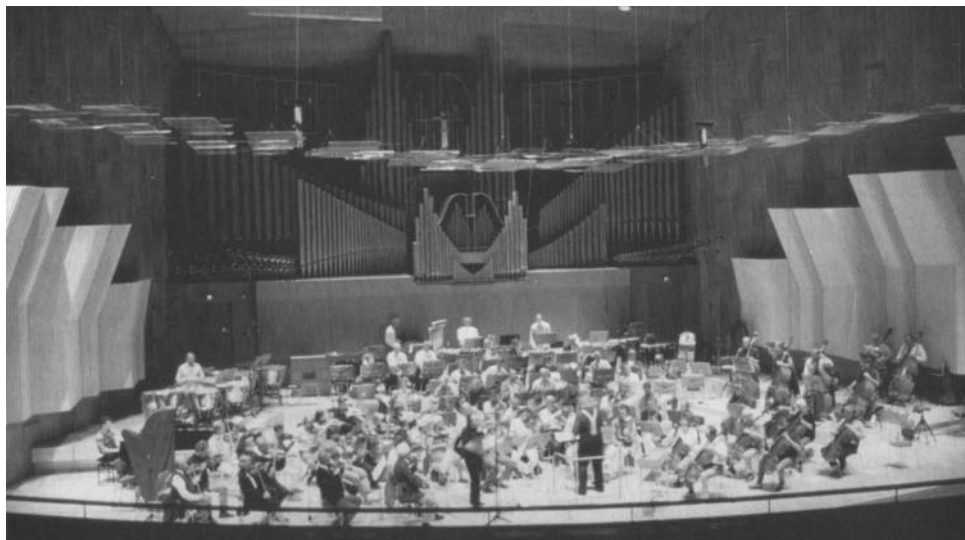
Fig. 15 Ampi riflettori laterali sul palcoscenico; la parte superiore dei riflettori è inclinata verso il basso per accrescerne l'efficacia (Radiohuset di Copenhagen: aperta nel 1945, 11.900 \text{ m}^3 , 1.081 posti, T_{Rm} = 1,5 \text{ s} ) (Beranek, 1996).
