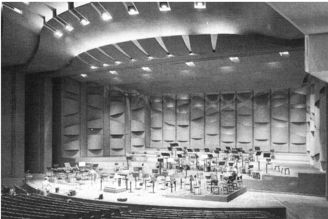
Fig. 16 Elementi di forma irregolare inseriti nelle pareti del palcoscenico, per favorire la diffusione del suono (Festspielhaus di Salisburgo: aperta nel 1960, 15.500 m 3 , 2.158 posti, T_{Rm} = 1,5 s) (Beranek, 1996).
