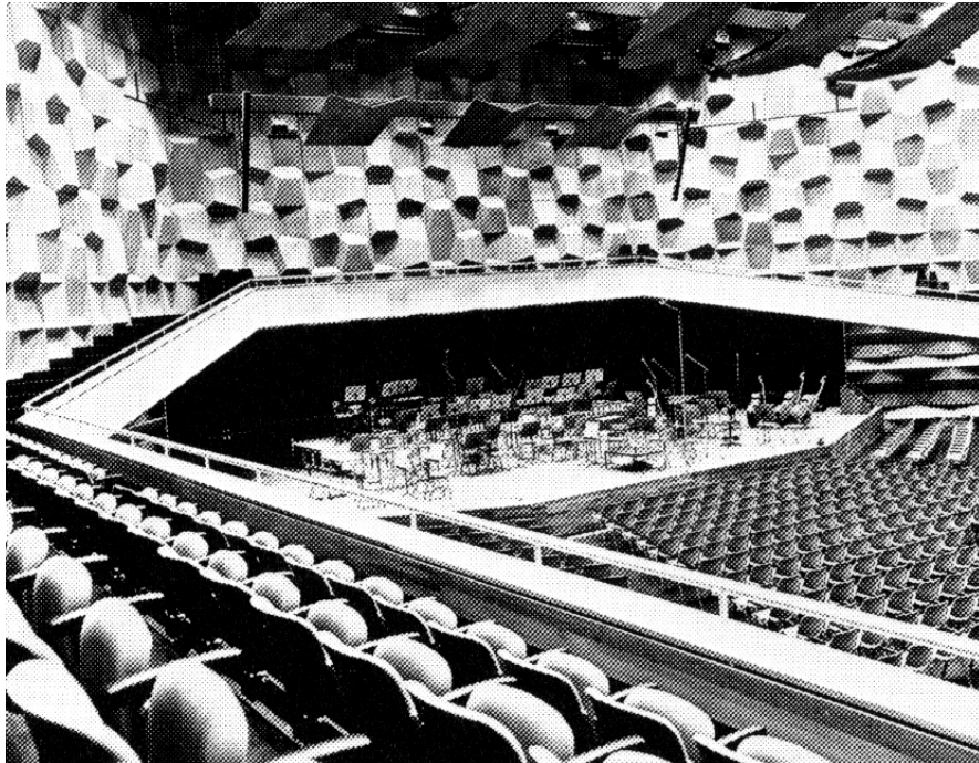
Fig. 12 Esempio di impiego spinto di strutture acusticamente diffondenti sulle pareti, nell'intento di creare un accentuato senso di impressione spaziale (Concert hall De Oosterpoort, Groningen, Olanda: aperta nel 1974, 14.010 m 3 , 1.200 posti, T_{Rm} = 2,1 s) (Talaske et al., 1982).
